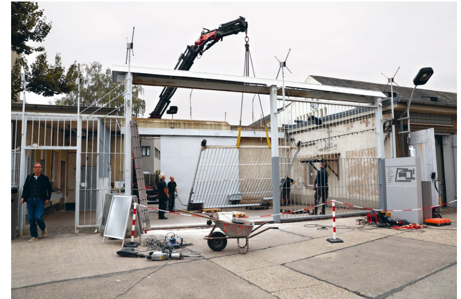
▲ Im Zuge der Restaurierungs- und Ertüchtigungsarbeiten wurde die Führungsschiene des Gefängnistores erneuert. Gedenkstätte, Berlin-Hohenschönhausen, 2020
