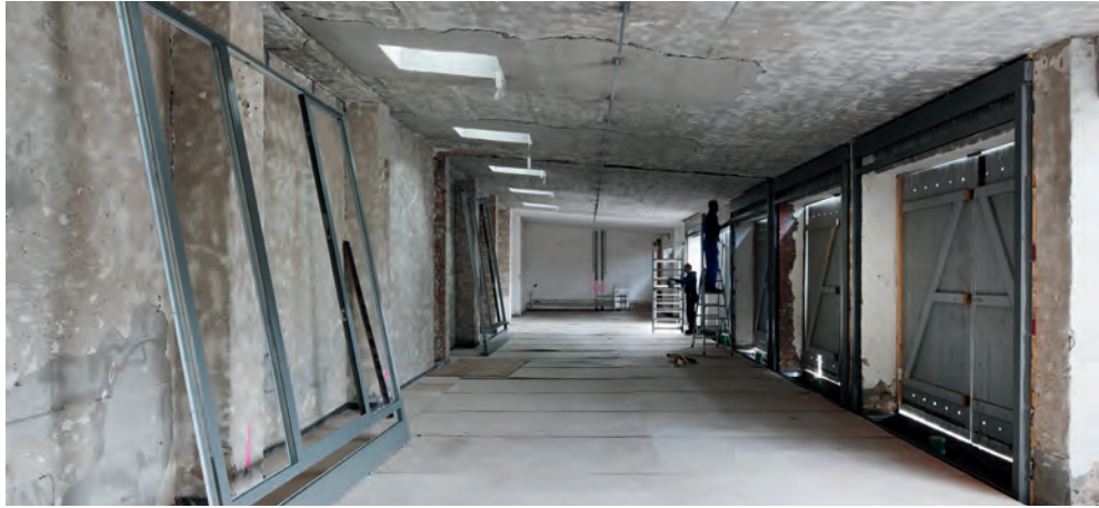
Bau des Besucherempfangs in den früheren Garagen des Gefängnisses
