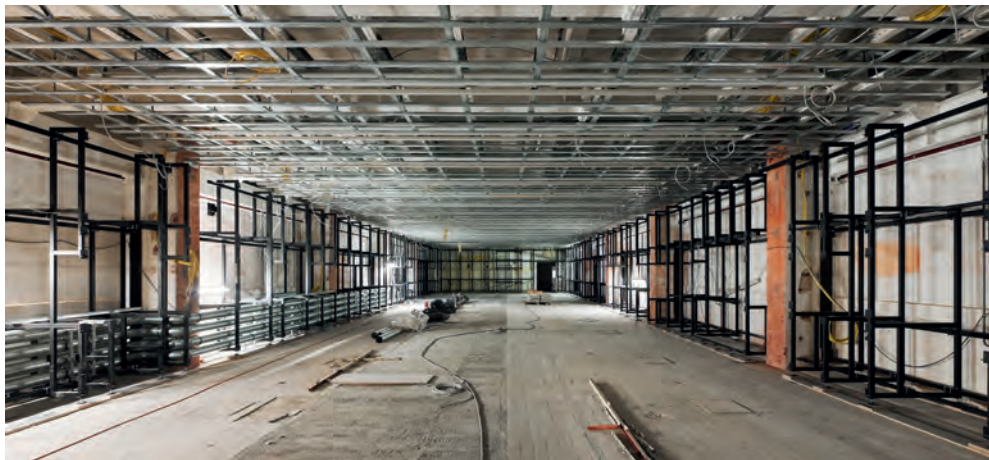
Umbau ehemaliger Lagerräume zur Ausstellungshalle
