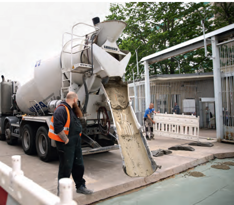
Verlegung einer neuen Fernwärmetrasse durch Vattenfall im Eingangsbereich der Gedenkstätte, 1. Halbjahr 2017
