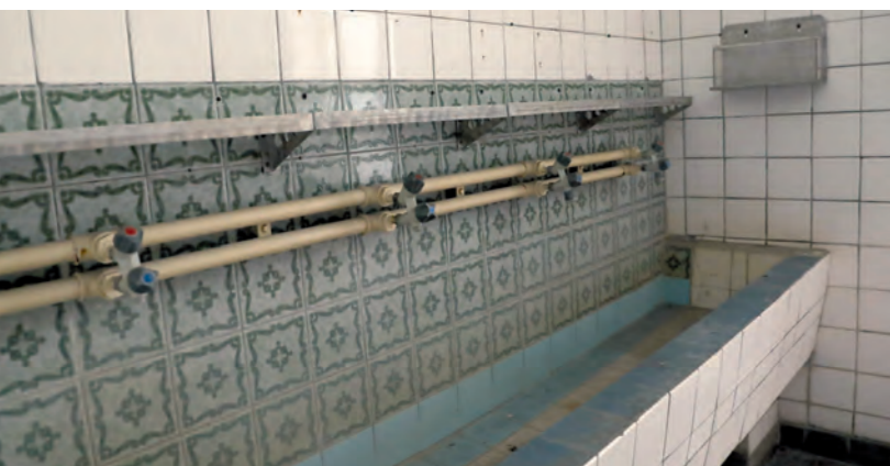
Unterkünfte des Männerarbeitskommandos, die im Rahmen von Sanierungsarbeiten ab Sommer 2019 wiederhergestellt werden
